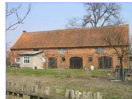
Budynek „stodoły” przed remontem
